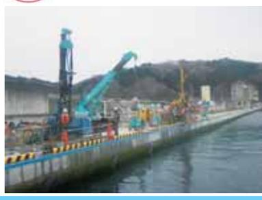
グラウンドアンカーは地中に造成するアンカー一体と構造物を引張材で連結して、構造物に引張力を与える工法で、港湾施設では岸壁や護岸の補強・補修に用いられている。アンカーの構造は、耐震性や繰返し荷重に対して有効なナット定着・摩擦圧縮型を採用している。従来の他の補強工法と比べて施工に必要な面積が小さく、エプロン等に施工範囲が及ばないため、既存施設に対する影響を最小限に抑えることができる。このような利点が評価されて、東日本大震災の復旧工事にも採用されるなど、多くの実績を有している。
