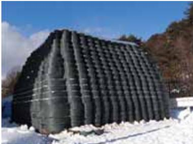
放射性物質で汚染された土壌や廃棄物の入った土のうは、降雨・地下水から遮断され、地震に強い構造（ジオテキスタイル補強も容易）を持つ強固な盛土で保管・隔離されます。盛土上部に通気・透水抑制シートを使用するため、盛土内は準好氣的雰囲気にて保たれ、メタンガス等の発生を抑制することができます。さらに、盛土の下部に吸着層を設置することで放射性物質の漏えいを防ぐため安心です。多機能盛土工法は、多機能盛土研究会によるものです。
