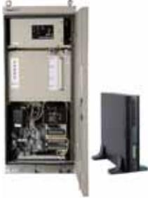
コンパクト発電装置は、非常用発電装置として必要な機器を全て縦型キュービクルに納めたコンパクト設計ですので、未活用空間への設置が可能です。屋内外の設置ができ、標準仕様で24時間、オプションで72時間の連続運転も可能です。また、全自動運転ですので停電検出後直ちに自動で始動し、発電電源に切り替えます。復電後は自動で商用電源に戻り停止します。ミニUPSとの組合せで無瞬断での電源供給もできます。
