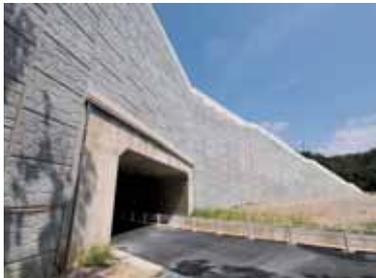
FILL WALL工法の画期的な点は、従来の盛土補強土壁工法が、支圧抵抗または摩擦抵抗のいずれか一方の効果により安定を保っているのに対し、支圧抵抗と摩擦抵抗の両方を組み合わせ、双方の効果で安定を保つ点である。盛土材と補強材との相互の拘束効果により、盛土全体を安定させていることに加え、支圧抵抗と摩擦抵抗の組み合わせにより補強材1本あたりの負担する引抜き力が増しているため、複合防災、生活道路盛土等にも有効な工法である。
