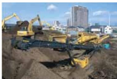
■技術の概要：本技術は現場内での「土砂の横持ち作業」や「リテラ・ガラパゴス等の成果品掻揚作業」あるいは「側溝等障害物を越えての土砂の運搬作業」において、ダンプおよびバックホウの台数を削減が期待できます。また、自走式であるため、作業現場の状況に合わせた設置が可能です。
