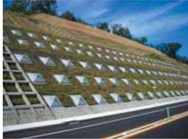
FFU受圧板は、ガラス長繊維で強化された独立気泡を持つ樹脂発泡成形品です。天然木材とプラスチックのすぐれた長所と特長を兼ね備えた新素材で、強く軽く耐食性にすぐれています。自由な着色で環境にマッチした美しい景観が得られ、カンタン施工で工期短縮が可能です。
