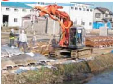
東日本大震災で発生した津波による堆積土砂を運搬する方法として、浚渫したのちに脱水して運搬する袋詰脱水処理工法が有効です。ジオテキスタイル製の袋で浚渫土などの高含水比建設発生土を脱水・減容化するとともに袋の張力を利用して盛土や埋土材料として有効利用することができます。
