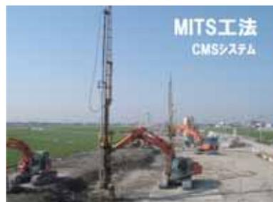
CMSシステムは小型改良機を使用し、攪拌翼とスラリー噴射による高速、高品質な改良体を造成する工法
