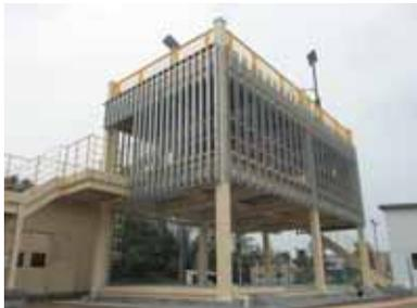
高い建築物や高台が無い沿岸部の住民を津波から守ることを目的とした避難タワーです。津波襲来時に想定される荷重（「津波に対し構造耐力上安全な建築物の設計法等に係る技術的助言」（国土交通省）により算出）に対して、耐震性と変形性能に優れた「コラム-H構造（鉄骨ラーメン構造）」を採用することで高い安全性を確保しています。また、柱梁接合部にダイヤフラム不要の「NDコア」を使用することで加工数・溶接箇所数が大幅に低減され、消費電力の低減と加工工期の短縮を実現できます。さらに、高い意匠性を備えた新建材を使用することで、環境にマッチした柔軟で多彩な発想を可能にします。
