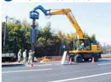
道路付属物（標識柱、照明柱、道路情報板柱、CCTV柱、信号柱等）の基礎工事で、軟弱地盤、狭隘（きょうあい）な場所に対応でき、あるいは埋設物を避けて構築する技術です。埋設物を避ける技術は、杭部とフランジ部の位置を最大500mmずらした偏心構造により、予定通りの位置に建柱が可能となります。また、東日本大震災の液状化が生じた地区で採用された本技術を調査した結果、液状化によって倒壊した事例は確認されておりません。
