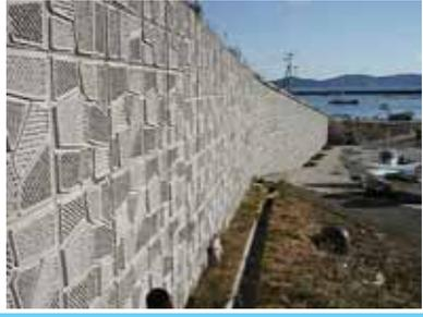
**逆T型擁壁のたて壁部分をプレキャスト製品とし、施工性・品質性を向上させた。**
