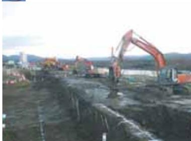
本技術は原位置土と改良材を攪拌混合して改良材の化学反応により土質性状を安定(改善)させる機械攪拌工法である。改良材供給方式は、スラリー噴射方式、粉体噴射方式、地表散布方式があり、スラリー噴射方式は平成23年度 推奨技術（新技術活用システム検討会議（国土交通省））に選定されている。
