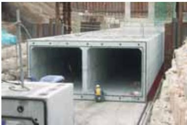
**樋管部を高強度のプレキャスト製品とし樋門を築造する技術である。**
