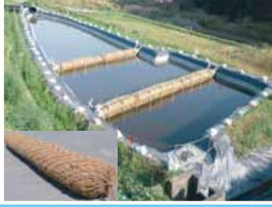
リサイクル天然ヤシ繊維を円筒形に圧縮成形し同質のネットで形成した天然繊維100%のバイオログフィルターに濁水を通過させる事により濁水中の浮遊物質を除去することが出来ます。フィルターの性能としては透水率が毎秒5mmで最大濁度低減率は45%の能力があります。設置可能箇所としては沈砂池・鋼製水槽・土側溝・水路などが挙げられます。フィルターの設置方法は木杭や単管パイプで固定するだけなので電源の確保や薬剤の投入機器の設置が困難な山岳や狭隘な現場条件でも適応が可能です。日常管理もフィルターの目詰りを目視確認する程度で専任の担当者を配置する必要もありません。
