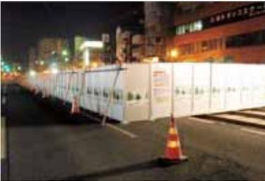
**組立・解体が容易にできるアルミ製吸音パネル**
