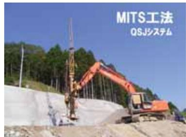
障害物（捨石、コンクリート）が混入している軟弱地盤に中圧スラリー噴射による改良体を造成する工法
