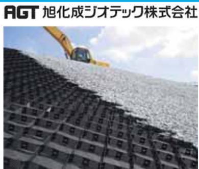
**ジオウエップ®はハニカム状に展開しセルの内部に砕石などの充填材を詰めることにより強度ある構造体を形成する工法です。**
