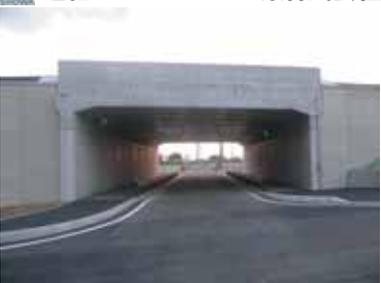
**規格化された最大内幅:13mの超大型プレキャストボックスカルバート。**
