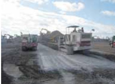
軟弱地盤や軟弱土を混合精度が良いスタビライザーを用いて改良する「浅層地盤改良工法」です。深度1.2mまで改良できます。主にセメント系や石灰系の固化材を用いる化学的固結改良工法と、単独では利用できない建設発生土と購入土を、粒度改良により再利用する物理的改良工法があります。クレーン等の大型重機転倒事故を防止する為の改良、構造物・建築物の基礎下・土間下の改良、道路の路体・路盤の改良、粒度改良による土質改良、社会問題となっている有害物質の封じ込めなど、幅広く利用できる工法です。
