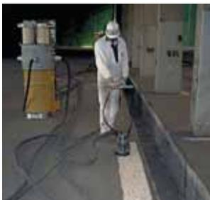
本装置は、スリーマイル原発事故で除染作業を安全かつ効率的に行うための技術として開発され、30年以上にわたりオンリーワン技術として数多くの実績をゆうしております。除染効果の高いグラインダー（Roto-Peen）、スクャブラー（Moose）等を「強力真空吸引装置（VAC-PAC）」と組み合わせることにより、コンクリートや金属面などの汚染面を「ハツる」際に発生するダストを強力に吸引し、直接ドラムに回収する技術です。作業環境において、ダストが舞わないため作業員の内部被ばくも防ぐ事が出来ます。また、汚染水などの回収も可能です。
