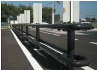
**狭小幅員にも設置が可能な中央分離帯に適した車両用防護柵(ガードパイプ)**
