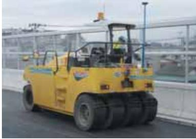
**3次元位置情報 (RTK-GPS、TS) を利用しローラの転圧状況をリアルタイムで表示・管理するシステム**
