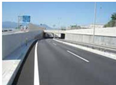
**角形断面のパイルを連続して壁状に設置することで、壁高9m程度までの道路擁壁や河川護岸等の自立式壁体構造物を大規模な仮設を必要とせず、最小用地幅で短工期、経済的に構築することができます。**
