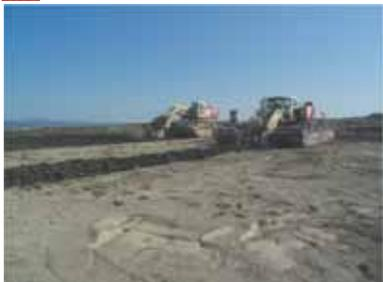
ソイルライマーは、泥土作業車のベースマシンに、ロータリー式攪拌装置を載せた構造で、ポンツーン式の履帯構造を用いて、接地圧を約0.01N/mm<sup>2</sup> (9.8kN/m<sup>2</sup>) まで低減したことにより、高含水、超軟弱ヘドロ上での混合施工が可能になりました。深度2.5mまで攪拌混合が可能であり、固化材と対象土を混合する事により、土の安定性と耐久性を増大させる工法です。超軟弱地盤の改良、浸漉ヘドロの固化、河川改修のヘドロ対策、湖沼堆積ヘドロの固化、有害物質の封じ込め等、多用途に利用できます。
