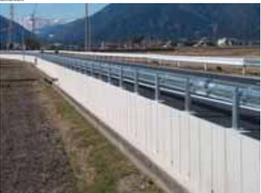
**車両用防護柵を直接設置可能としたL型擁壁**
