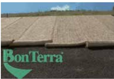
**法面の浸食防止・植生回復を目的とした、天然素材を使用した表面被覆資材。**
