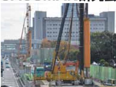
交差噴流とは、一般の噴射式攪拌工法が水平方向に固化材を噴射させるのに対し、交差噴流は上下2段のノズルから斜め方向に交差するように固化材を噴射させ、改良範囲をコントロールする方式です。
