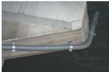
**屋外排水配管用塩ビ製フレキシブルパイプ。地震による設備配管の二次災害を防ぐ、免震継手として使用可能。**
