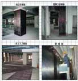
MARS工法は耐震性の低い構造物や老朽化した構造物を、効果的に補強する目的のため、材料メーカー、ゼネコン、施工会社のノウハウを結集したMARS研究会により開発された、(財)日本建築防災協会技術評価習得の補強工法です。高強度で軽量かつ耐震性に優れた炭素繊維シートを貼り、樹脂で接着する事により建物の独立柱をはじめ、壁付き柱、梁、壁を補強し耐震性を向上させます。炭素繊維シートが高弾性、高強度(普通鉄筋の10倍)なので補強厚を薄くでき補強による断面の増加を最小限に抑えられます。また、金属を使わないため錆の発生がなく塩害対策にも効果を発揮します。
