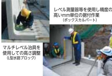
レベル測量器等を使用し精度の高いmm単位の据付作業(ボックスカルバート)
