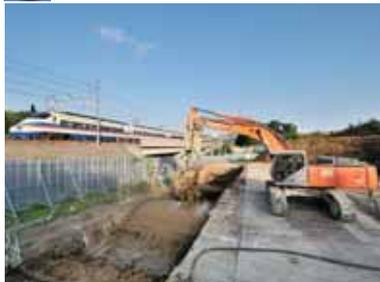
軟弱な互層地盤を鉛直方向に攪拌混合して均質な改良体を連続的に造成するパワーブレンダー工法（スラリー噴射方式）にボイラをプラスしてセメント系改良材の特徴である「養生温度が高いほど水和反応が活発になる」ところに着目した技術である。
