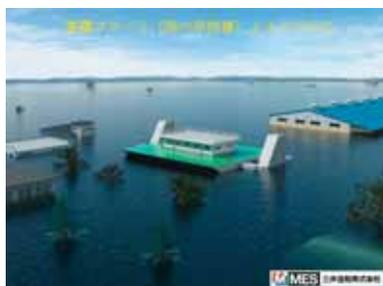
津波や洪水襲来時に浮き上がり、浮体上及び内部に設けた施設等を水没から守る「陸の浮棧橋」
