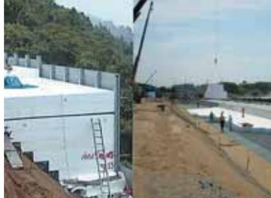
土砂の約1/100の重量で荷重軽減として軟弱地盤対策、埋設構造物の保護に、土圧軽減として護岸背面や橋台背面、道路拡幅に使用されます。工場で品質管理されたEPSブロックを現場で人力施工するため、現場での品質管理がしやすく工期短縮も可能です。施工実績も豊富で1985年から約25年で500万㎡の施工実績があります。復旧・復興に関しては、道路崩壊部の復旧や復興道路の盛土、護岸背面の土圧軽減や堤防道路の盛土、被災地街づくり分野の道路や公園整備等にご採用が可能です。
