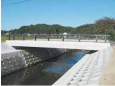
支間長が20m程度までの複合門形ラーメン橋の築造工法であり、上下部工の剛結工法が単純・確実であるのが特徴である。上下部工を一体化したことにより地震や津波に対して強い構造である。主桁は、H形鋼に孔明け加工を施したものを採用しているため、材料調達が容易であり、桁製作日数も短期間で済む。主桁重量が軽く取扱いも容易なため、狭小箇所での架橋が可能で、現場施工は短期間で済む。下部工や基礎工の縮小、支承や伸縮装置の省略など建設コストや維持管理コストも大幅に低減できるため、新設橋や既設橋の架替えに適する工法である。
