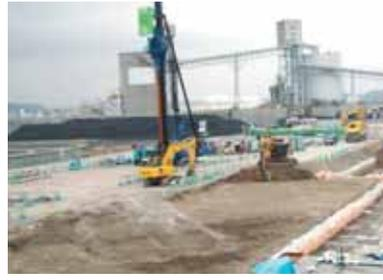
SDP-N工法は、回転駆動装置と強制貫入装置を組み合わせた回転貫入装置により、軟弱地盤にケーシングパイプを静的に貫入させ、改良杭造成時においても改良材の排出・打戻しを静的に行い、拡張された締固め杭を造成する環境に配慮した静的締固め地盤改良工法である。低振動低騒音で施工ができること、先端部に特殊機構を備えているため杭間地盤の締固め効果の向上が期待できること、改良材として、砂や碎石の他に再生碎石等のリサイクル材を有効活用できることを特徴とする工法である。
