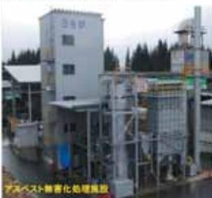
●アスベスト無害化工法：投入設備一体型溶融炉によるアスベストの高効率無害化処理システムは、負圧管理された投入設備内の破砕機でアスベスト含有保温材等を前処理(破砕)し、溶融炉に連続定量供給して無害化処理するものです。環境省平成22年度次世代循環型社会形成推進技術基盤整備事業の助成を得て、アスベスト含有保温材等を用いた実証試験を行い、環境省無害化処理認定制度で要求される無害化性能を満足することを確認しています。また従来設備と比較して消費燃料削減、処理費用軽減を図っています。無害化処理認定制度の適用を得て早期の事業化を予定しています。
